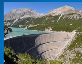
Cancano Dam (SO)
